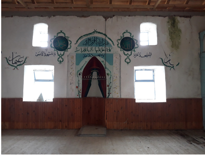
Resim-2. Simnitsa Camii mihrap kısmı
